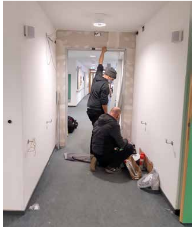
Einbau einer Brandschutztür.
